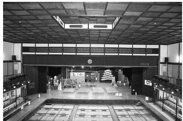
▲ 内部西面 (2 階向棧敷から舞台を見る)
