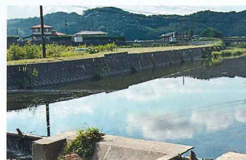
城林井堰の現在の様子
