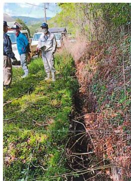
『蓋』設置前の用水路
