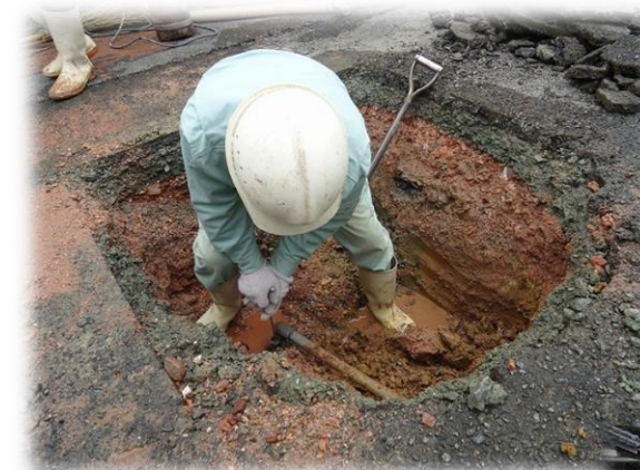
管渠埋設作業風景
