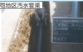
庄司地区污水管渠
