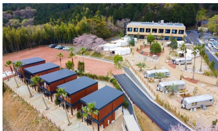
いづかスポーツ・リゾート ザ・リトリート
