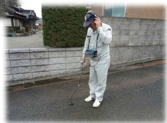
漏水調査の様子
