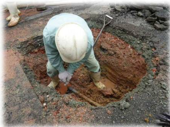
管渠埋設作業風景
