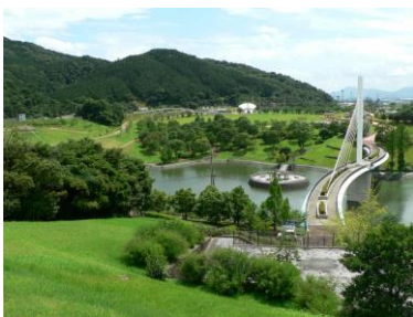
▲広域公園(筑豊緑地)
