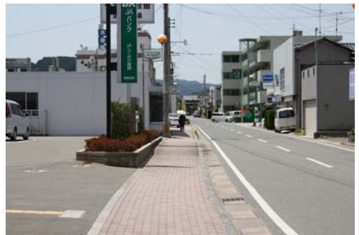
支所周辺道路のバリアフリー化
