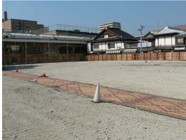
平成 20 年 4 月本町商店街他火災跡
